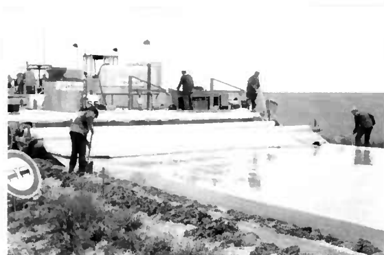
Chaussée en béton
