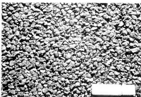
Béton bitumineux drainant (0/10)
