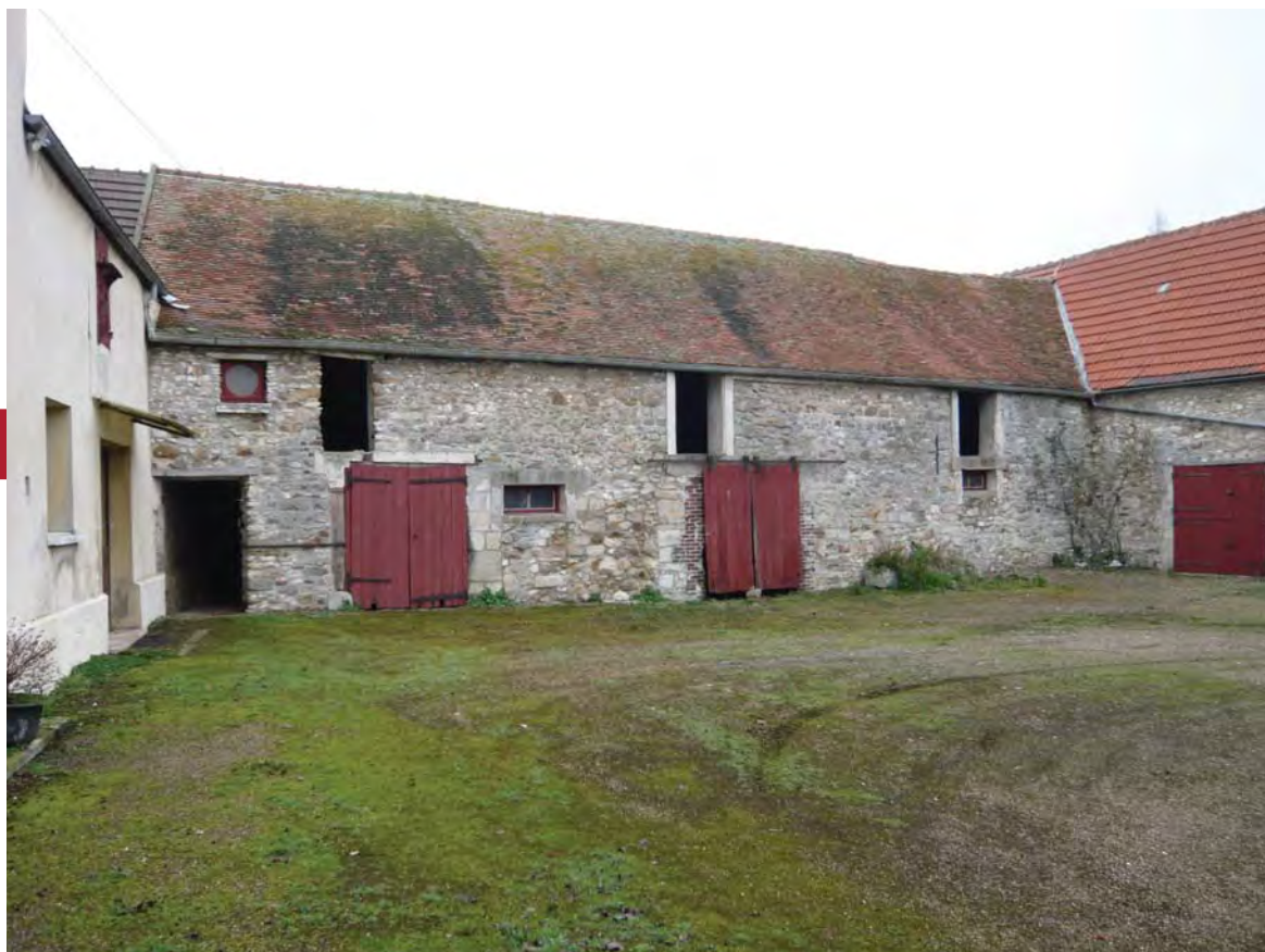
Façade des étables, ferme de Boasne, Montépilloy
