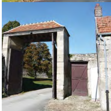
Portail, ferme du Courtillet, Vineuil-Saint-Firmin
