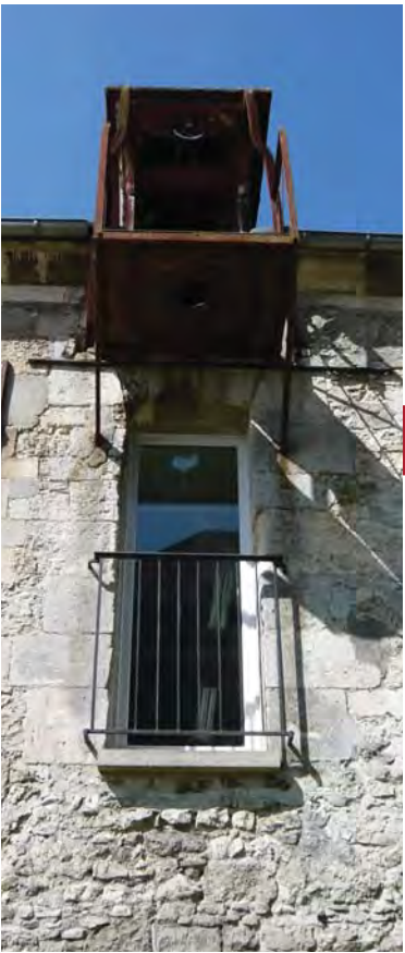
Ecuries Hauteur des murs gouttereaux : 4 à 7 m Longueur du bâti : 10 à 20 m Largeur du bâti : 6 à 7 m
