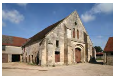
Grange monumentale à deux bas côtés, ferme de Fourcheret, Fontaine-Chaalis
