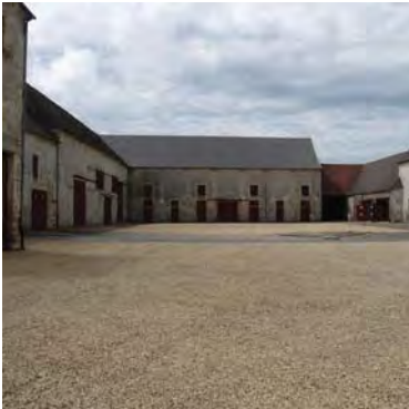
Cour minérale et écuries, ferme de Chamicy, Rully
