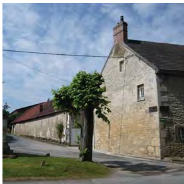
Bâtiments avec peu d'ouvertures, ferme de Rhuis, Rhuis
