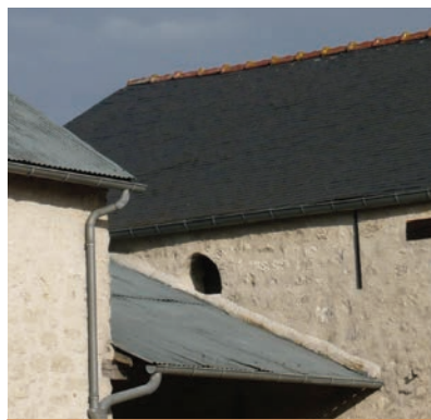
Toitures en tôle (à gauche) et ardoise (à droite)
